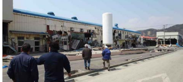
石巻港から300mの第二工場。一帯がすでにマイナスの海拔になってしまっているため工場はあきらめるものの、壁を壊して瓦礫を撤去、中にある貴重な機械を引き出すことに。
