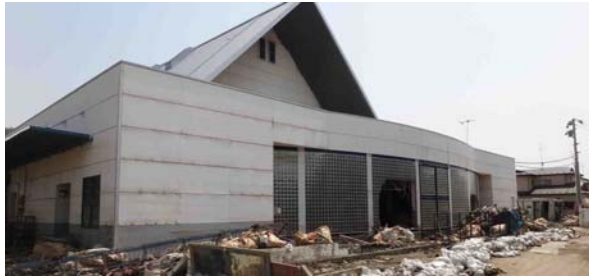
高橋徳治商店本社工場。地盤沈下1.3mで満潮時にはすぐそばまで海水が。工場内は津波でずまじい。しかしここから再建する方針。
