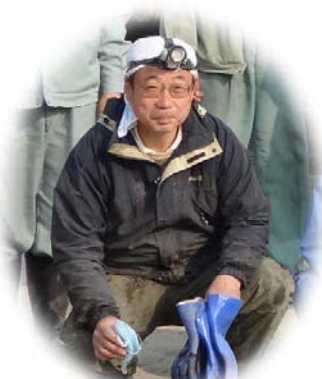
ガレキ撤去作業の合間に高橋さん(4/20)
