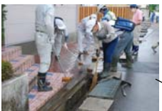
家の前の側溝除染
