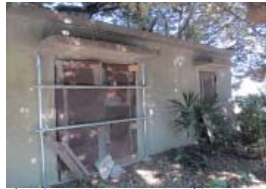
ガス庫。言われなければわからない倉庫でした。
