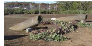
畑に突き出す煙突?・・・この地下に劇薬の燃料庫が。その換気筒が今も
