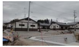
高台に建設されている復興住宅。
