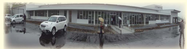
高橋徳治商店新工場。2013/7/5（新工場落成・東松島）
