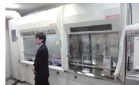
前処理で発生するガスを吸引フィルター処理する施設
