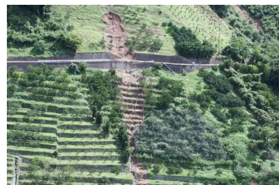
畑が抜けて土砂崩れが起こっている。
