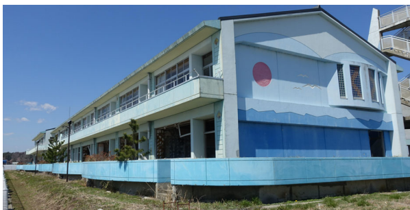
↑津波被害をうけた浪江町請戸小学校 震災遺構として残すか検討されている状況です。
